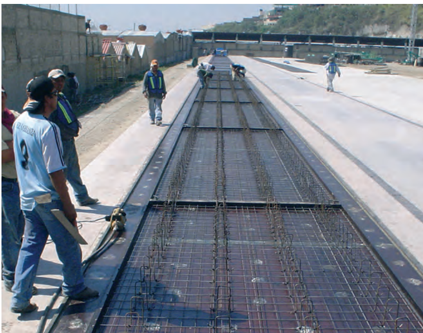
Fabricación de prelosas pretensadas (Guadalajara, México) Manufacture prestressed precast slabs (Guadalajara, México) Produkcja filigranu sprężonego (Guadalajara, Meksyk)
